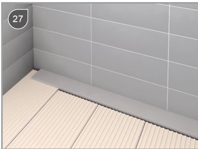
Spread the tile adhesive (EN 12004 C2).
